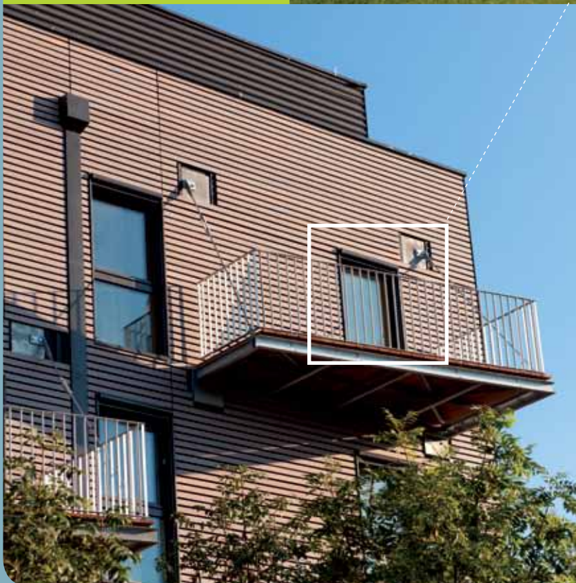
Résidence Eco-Logis à Nancy Bâtiment certifié par le Passivhaus Institut 8 logements collectifs Mise en service novembre 2010
