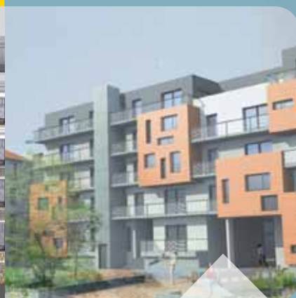
Restructuration de l'îlot Oudeville à Villers-lès-Nancy (côté cour) Projet de création de 43 logements collectifs BBC
